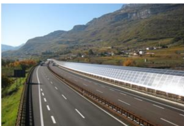
impianto su autostrada (barriera acustica)
